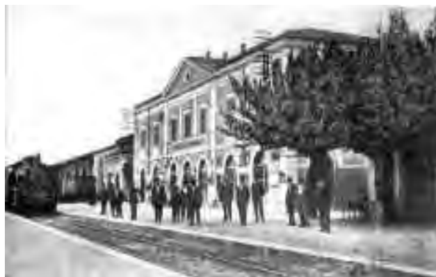
Fig. 7. La stazione di Frosinone
