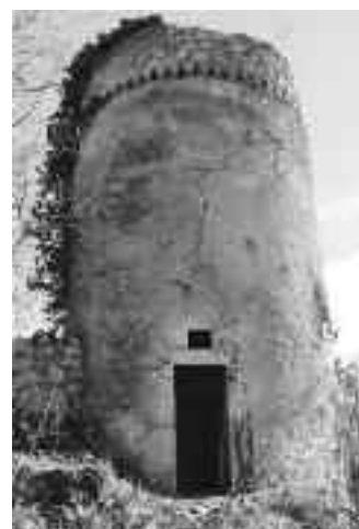
Fig. 17. Balsorano Vecchio. Torre Palombara
