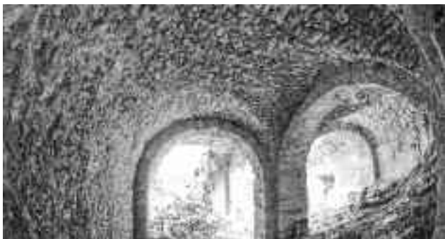
Fig. 8. Balsorano Vecchio, via Ravone. Interno dell'edificio
