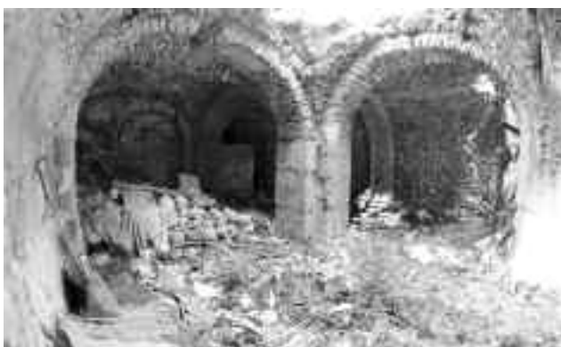
Fig. 10. Balsorano Vecchio, via Ravone. Interno dell'edificio
